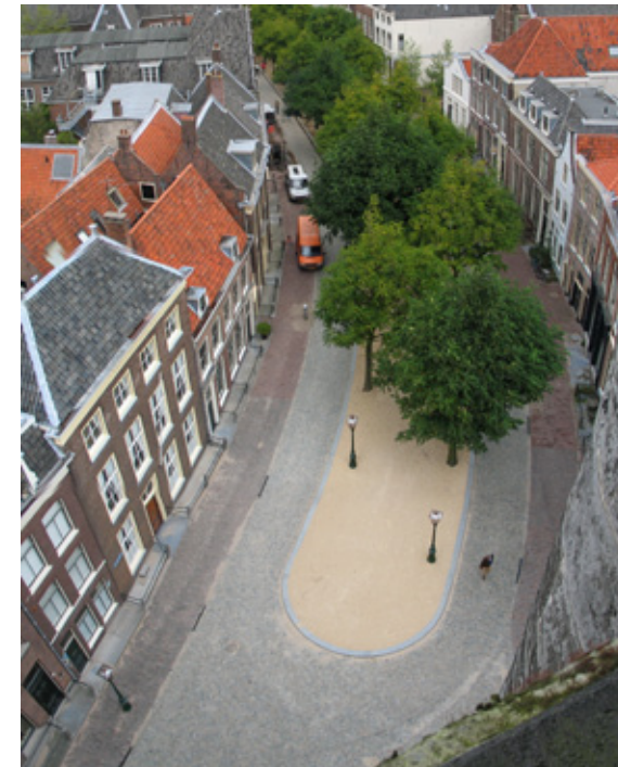
Hooglandsekerkgracht heeft als basis de binnenste beter mix en luikse kei, en is verbijzonderd door de bomen in halfverharding te plaatsen met een natuurstenen opsluitband
